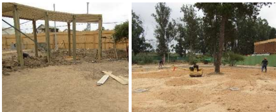
Construcción Plaza Acceso Catapilco. Inicio 2023
