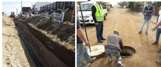
Construcción Extensión Redes de Agua Potable y Alcantarillado La Laguna. Inicio 2022
