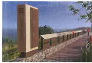
Construcció Segunda Etapa Pasarela Borde Humedal
