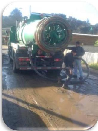
Trabajos Camión limpia fosas, para eso se trabajó con camión extrayendo toda el agua acumulada en los puntos bajo cota.
