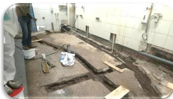
Trabajos de conexión alcantarillado interior Restaurante
