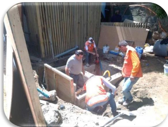
Trabajos de conexión alcantarillado interior
