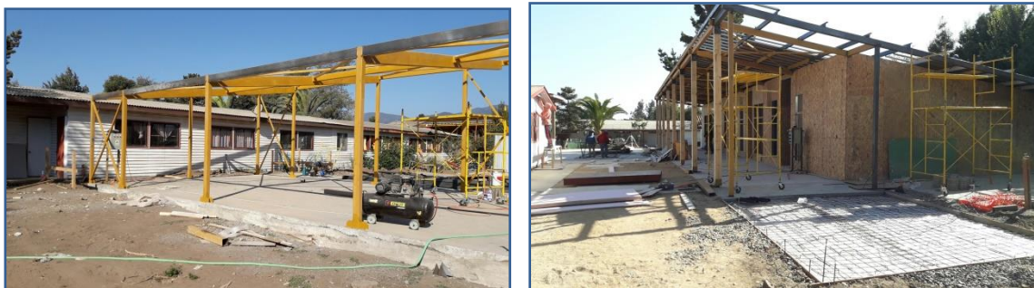
Fotos de los inicios de la obra Ampliación y Normalización de la Escuela Aurelio Durán de La Hacienda
