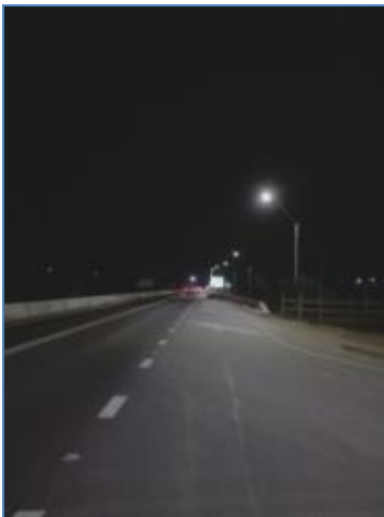
Proyecto Mejoramiento Alumbrado Público La Retamilla (Financiamiento Municipal)
