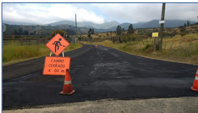
En la foto: Sello de Lechada Asfáltica
