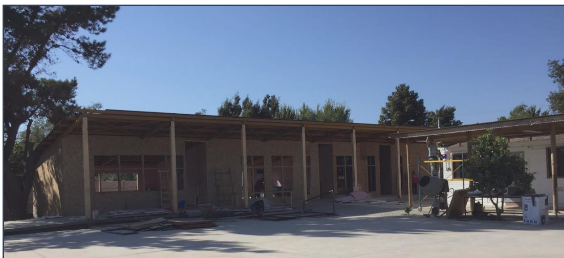
Foto estado de avance de la obra Ampliación y Normalización de la Escuela Aurelio Durán de La Hacienda
