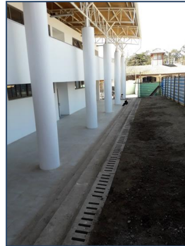
Foto: Arreglos de mitigación aguas lluvias.
