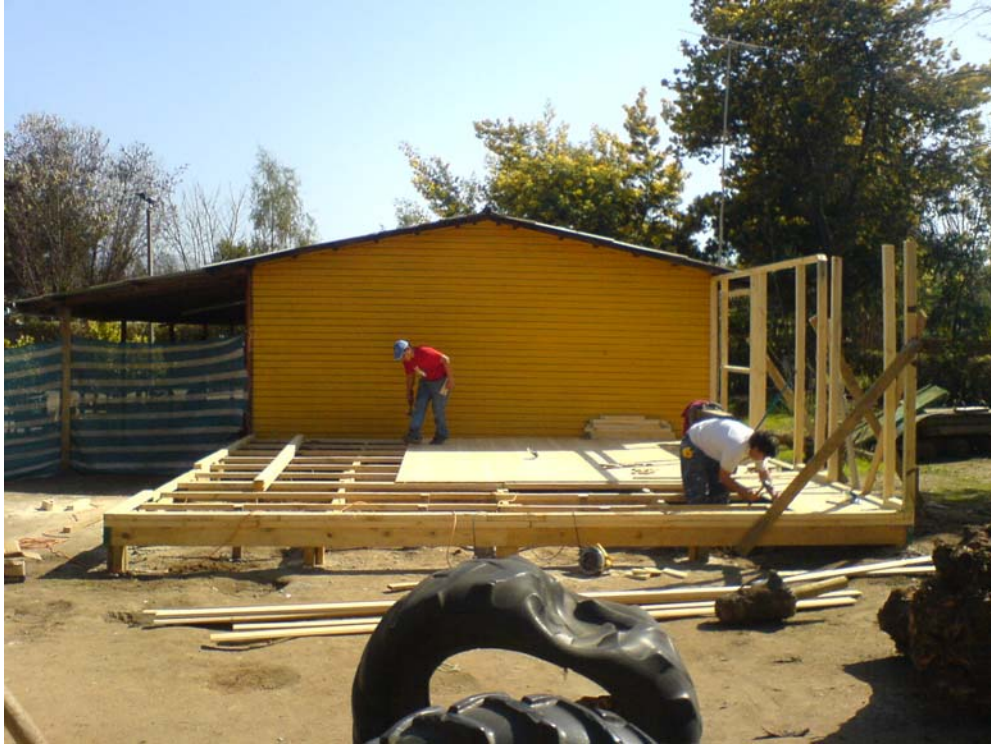
Obras de construcción para la ampliación de la Escuela Aurelio Duran del Asentamiento Catapilco
