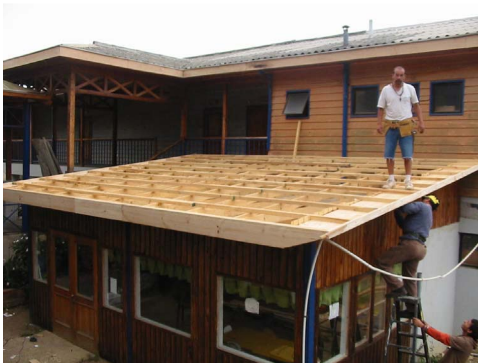
Obras de recambio de techumbre en el jardín Infantil del Liceo de Zapallar
