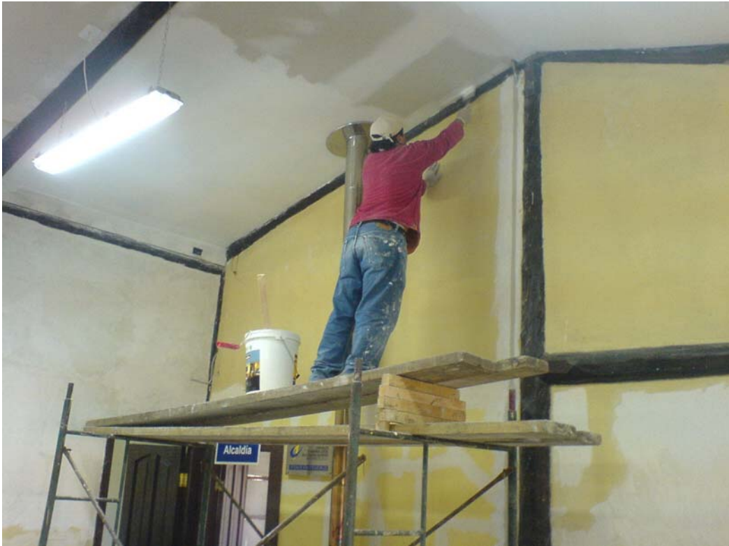
Obras de mejoramiento del cielo de la Oficina Municipal de Catapilco
