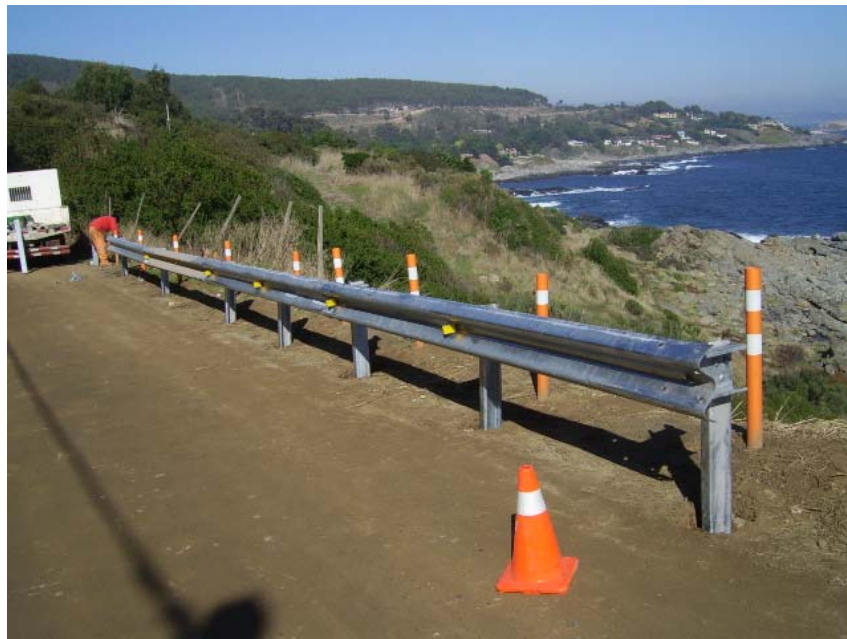
Instalación de barandas de seguridad en Av. Carlos Ossandon
