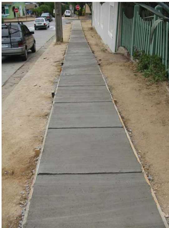
Construcción de veredas en calle Germán Riesco
