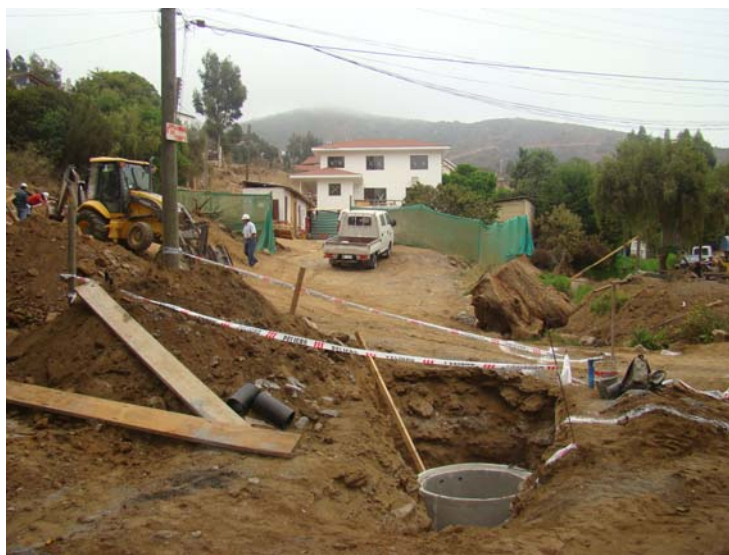
Obras de Construcción de Colectores y Planta Elevadora en el sector El Paihuenal
