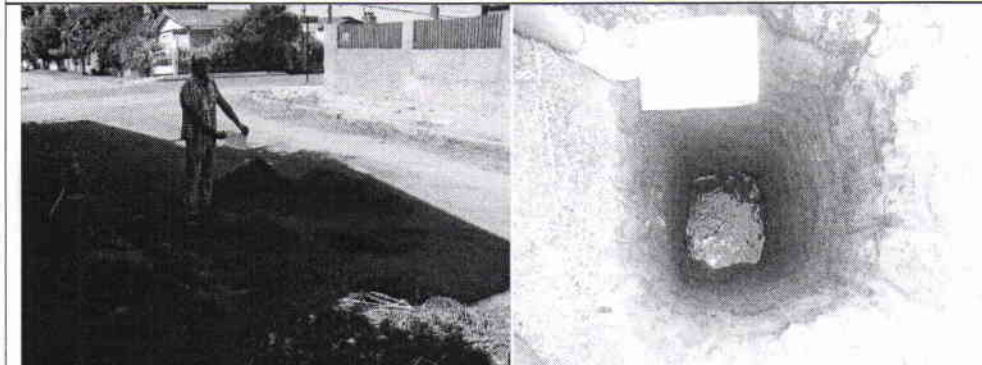
Calicata C-8 Los Pinos 1459
