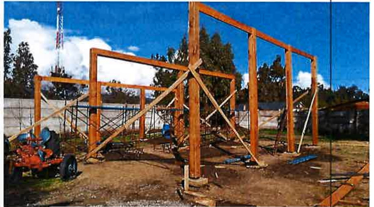
Imagen N°12: Aula Rural en Construcción
