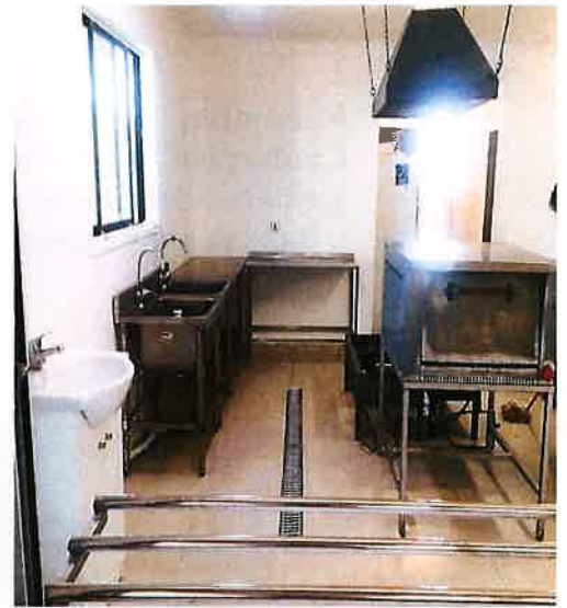
Imagen N°4: Cocina Escuela Aurelio Duran
