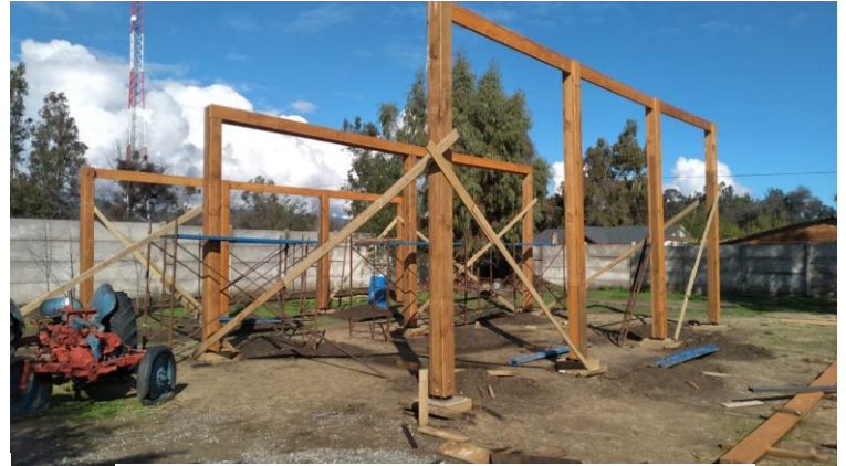
Imagen N°12: Aula Rural en Construcción
