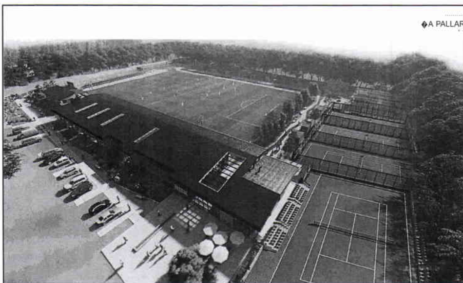
Construcción Centro Deportivo Cachagua
