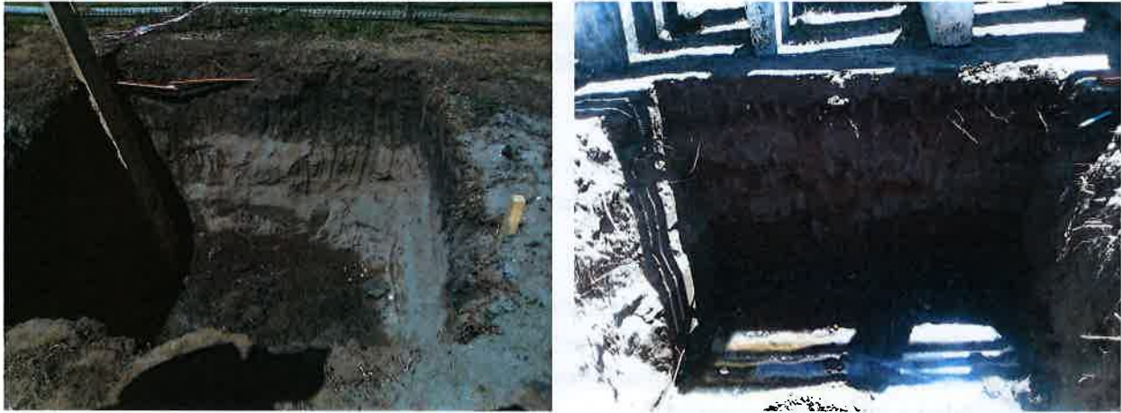
Imágenes fundaciones torres de iluminación (2,5x2,5x2,5mt)
