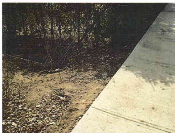
Figura 1: Canal existente a rehabilitar
