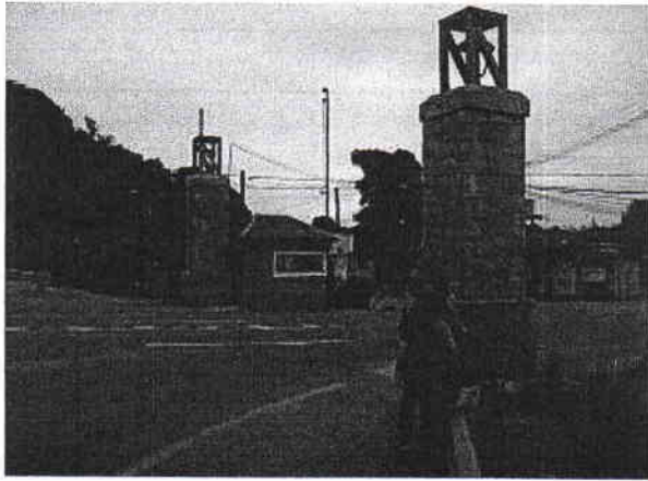
Foto 1.- Estado actual del portal de acceso a Laguna de Zapallar, sin la estructura de techumbre instalada.
