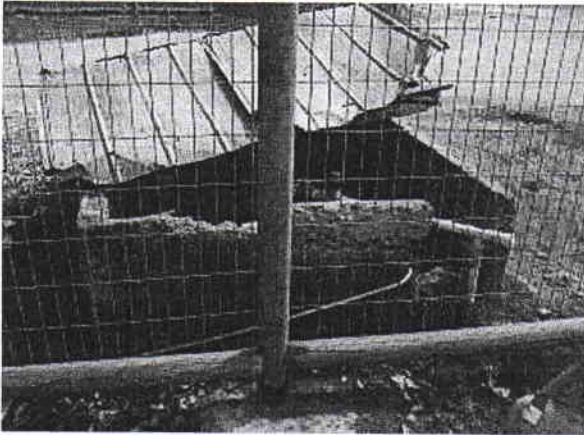
Foto 12.- Estado actual de la caseta para red de agua potable.
