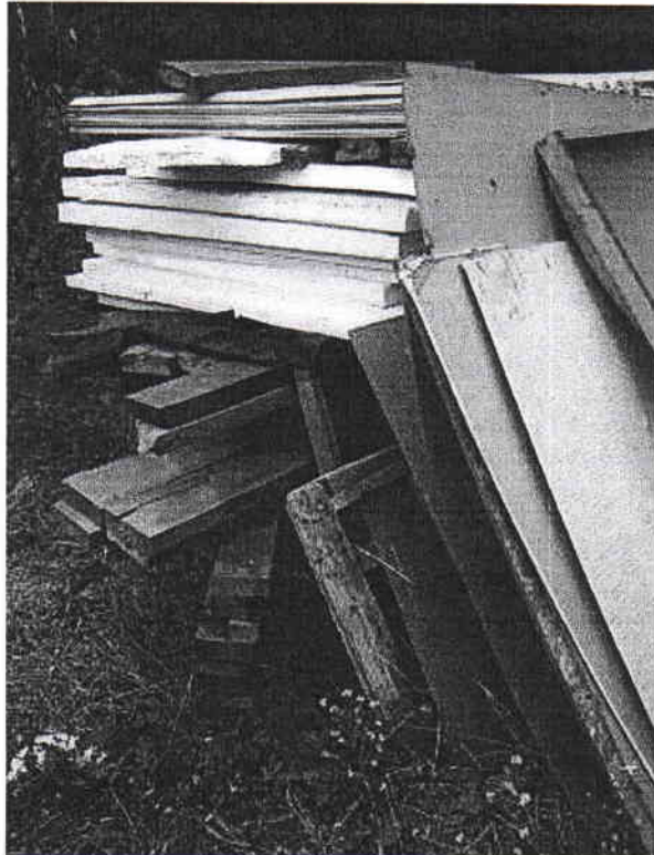
Foto 6.- Cerchas de madera de la estructura de techumbre que se conservan en el taller del contratista.
