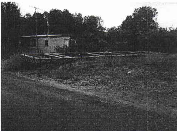
Foto 3.- Actualmente la estructura metálica del portal, está ubicada en un bien nacional de uso público.
