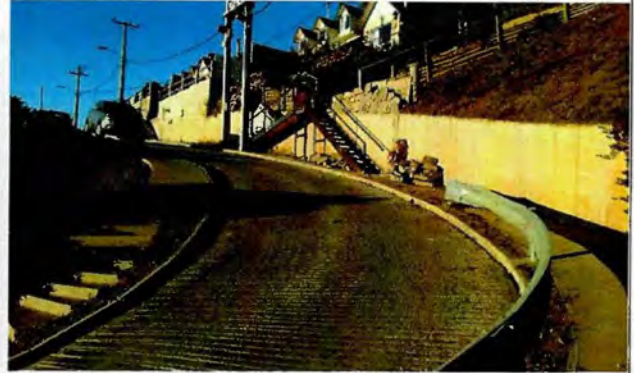
Fotos N° 5 y 6: Inexistencia de canaleta de hormigón para el tramo 5.
