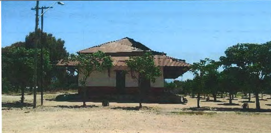
Foto N° 7: La antigua Estación de Catapilco solo contemplo 5 focos haluro metal de 400 W con sus respectivos canastillos de protección los cuales se ubicaron en las fachadas sur y oriente.
