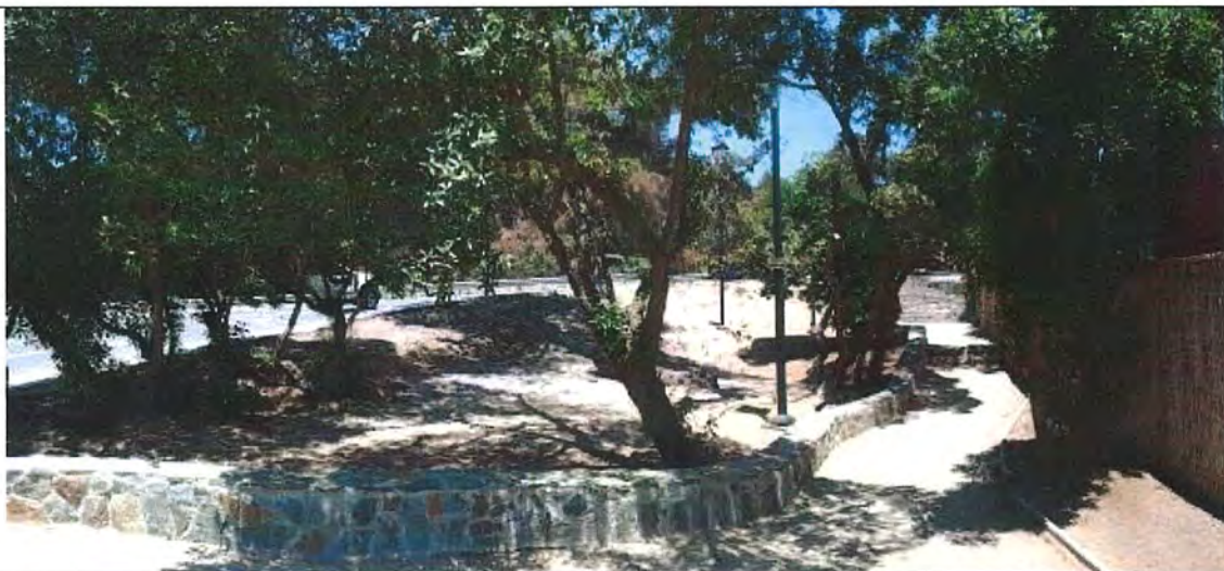
Foto N° 10: Los únicos trabajos ejecutados corresponden a los realizados en el Acceso de Zapallar
